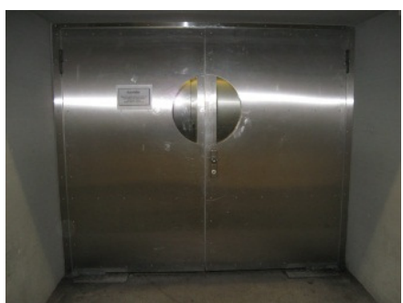
Eingang Haus A Foyer A1
