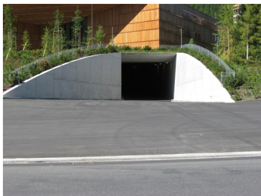
Einfahrt Tunnel zum Lieferanteneingang
